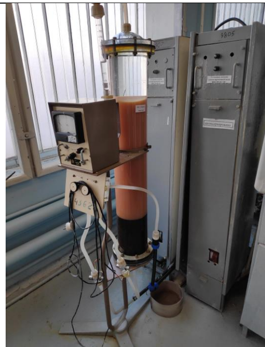
Установка финишной очистки воды УФ-400
