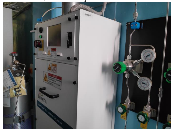
Система очистки технологических газов
