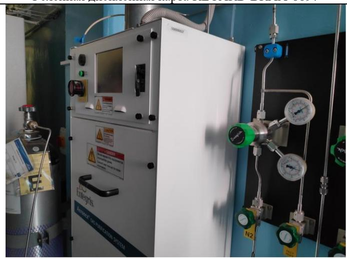
Система очистки технологических газов
